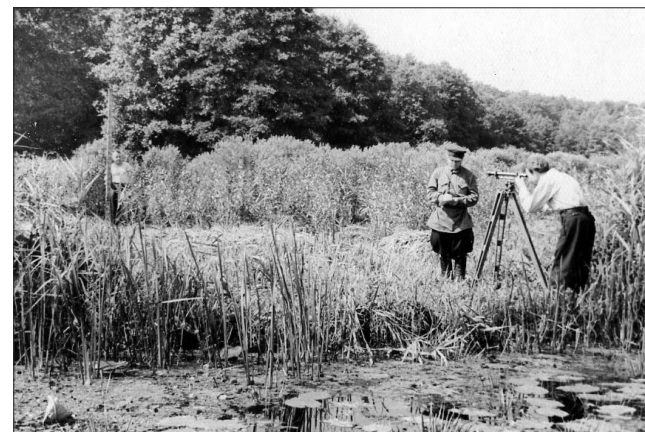
Подготовительные работы к реконструкции пойменных лесов – нивелировка поймы р. Усмани.
